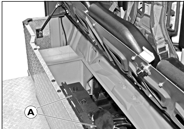
[267] Einbauort der Fahrzeugbatterien in Fahrgestellen von Iveco
